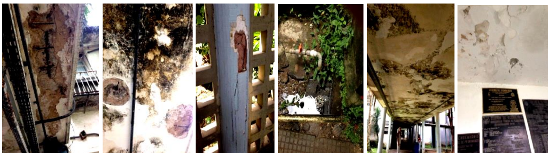
Figura 13 (5) – Fotos do Centro de Tecnologia e Geociências
