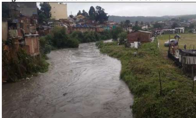
Figura 1: Enchente de 2022 em Vitória de Santo Antão-PE
